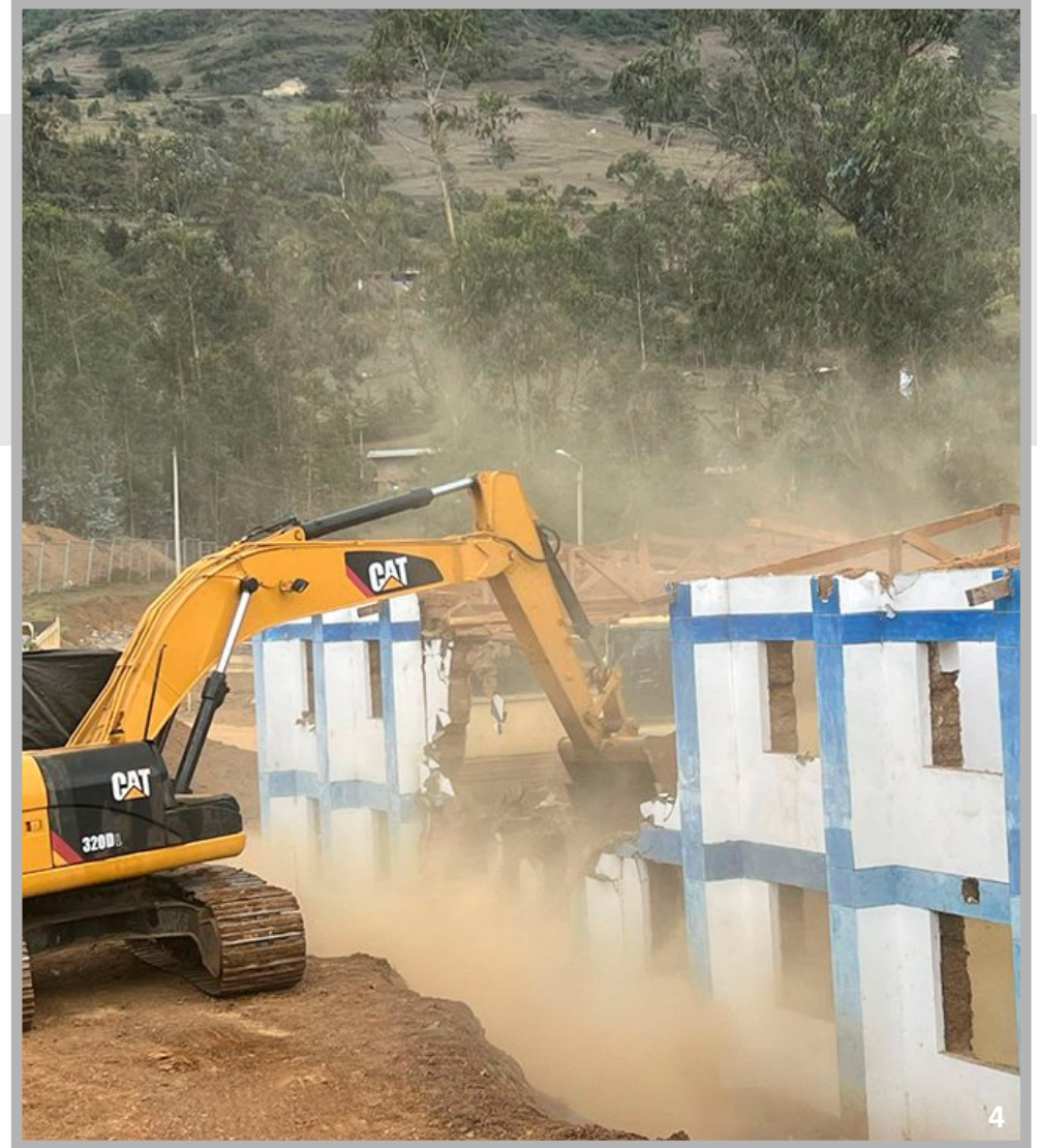
3. Inicio de los trabajos de excavación en la zona del proyecto 4. Demolición de la infraestructura existente
